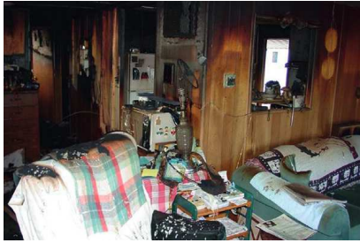
Abb. 7: Brandraum mit intensiver thermischer Aufbereitung ohne flammende Verbrennung; die angekohlten Gegenstände haben massiv Pyrolysegase freigesetzt, die sich jedoch aufgrund unzureichenden Sauerstoffangebots nicht entzündeten (Foto: Gresham, Fire & Emergency Services)
