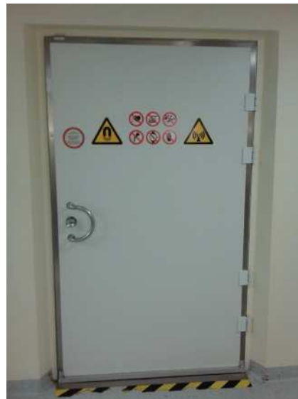
Abb. 5.2/1: Zugangstür zur MRT mit ASR-Kennzeichnung (Foto: Weinz, Niederwörresbach)
