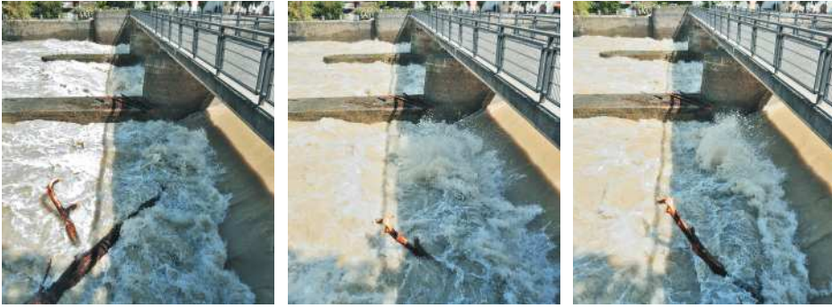
Abb. 14 Schwimmfähige Gegenstände (hier ein Baumstamm) können stundenlang in einer Wasserwalze herumgeschleudert werden (siehe Bonusmaterial im Download-Bereich), Menschen ebenfalls! Eine Rettung aus einer derartigen Wasserwalze ist selbst für den professionellen Wasserrettungsdienst nur mit hohen Sicherheitsmaßnahmen möglich, eine Selbstrettung durch den Verunfallten meistens nahezu ausgeschlossen.
