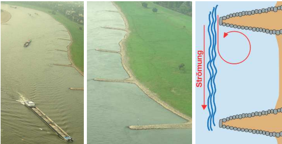
Abb. 15 Flussbuhnen zur Reduktion der Strömung am Flussufer erzeugen Wirbel hinter den Buhnen, die einen Schwimmer an die Buhne und gleichzeitig unter Wasser drücken können. Die Fotos zeigen Flussbuhnen am Rhein (links) sowie im Ausschnittfoto (Mitte); die Strömungsverhältnisse an Flussbuhnen sind in der rechten Skizze eingezeichnet.
