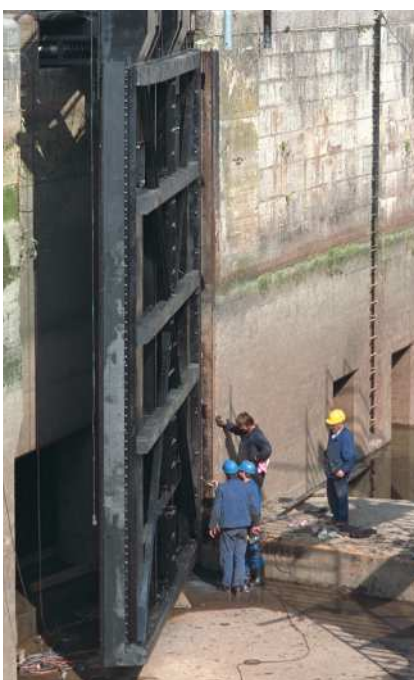
Abb. 12 Beim Schleusvorgang fließt das Wasser durch Öffnungen am Schleusenboden aus der Schleusenkammer. Gerät eine Person dabei in diesen Wassersog, muss umgehend der Abbruch des Schleusens veranlasst werden (hier die Schleuse bzw. das untere Schleusentor mit Abfluss- und Ausströmungsöffnungen im wasserlosen Zustand bei Wartungsarbeiten).
