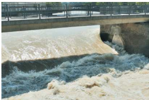
Abb. 13 Das Wehr in Landshut bei unterschiedlichen Wasserständen der Isar: oben „ohne Wasser“ und in der Mitte bei „normalen Wasserverhältnissen“. Im unteren Bild lässt sich die massive Wasserwalze bei Hochwasser bei Kenntnis der wahren Fallhöhe bzw. der Wasserstandsverhältnisse erahnen (zum Verständnis: in Landshut teilt sich die Isar in zwei Flußarme - der linke Flußlauf fließt über das Wehr, siehe Abb. 63)
