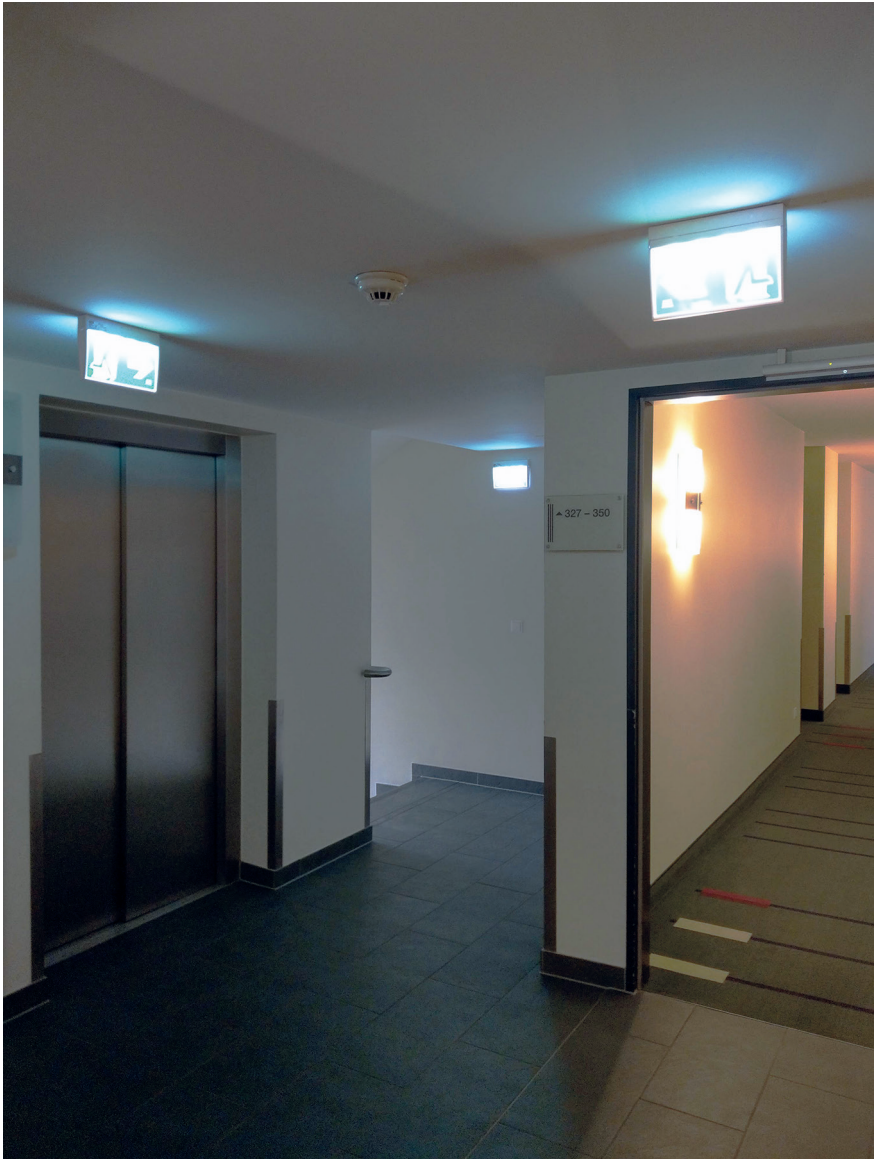
Abb. 29: Ordnungsgemäße Kennzeichnung der möglichen Richtungswechsel.
