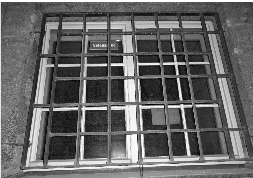
Abb. 5.12 Die Benutzbarkeit des zweiten Rettungsweges ist nicht möglich (= konkrete Gefahr).
