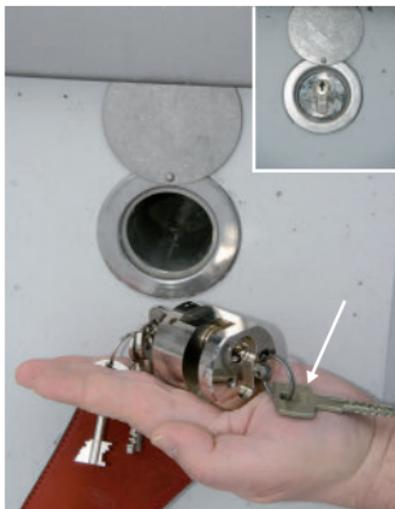
**Bild 7:** Beispiel für ein FSD 1, integriert in eine Gebäudewand. Im Vordergrund ist der Objektschlüssel zu sehen (Pfeil). Das kleine Bild zeigt das FSD 1 im verschlossenen Zustand.
