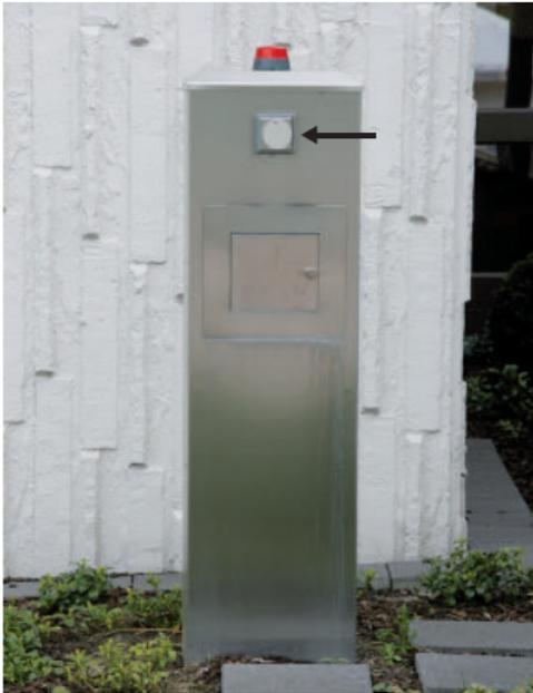
**Bild 3:** Beispiel für den Einbau eines FSE in einer Edelstahlsäule (Pfeil). Darunter befindet sich ein FSD 3.
