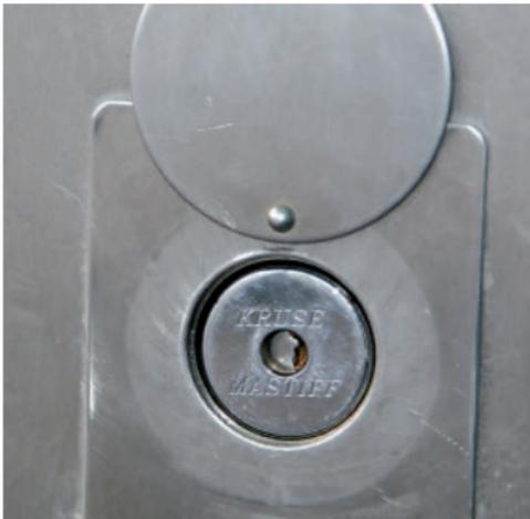
**Bild 4:** FSE in der Ausführung mit Steckschloss
