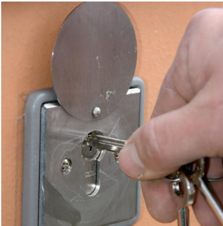
**Bild 5:** *FSE in der Ausführung mit Profilhalbzylinder. Die Auslösung erfolgt durch einen Schlüsselschalter.*
