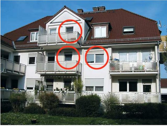
**Bild 2** Erkundung erreichbarer Zugänge an der Gebäuderückseite
